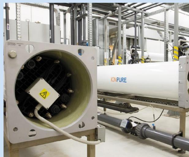
**3. Электродеионизация:** доочистка пермеата до требуемых норм качества обессоленной воды. Процесс предусматривает электрохимические ионообменные реакции. Ионообменная смола удаляет катионы и анионы из исходной воды, а электрический ток непрерывно регенерирует ионообменную смолу.
