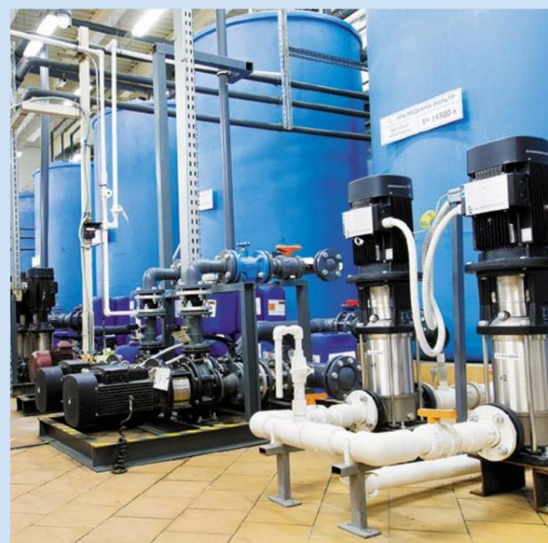
**1. Ультрафильтрация:** на ультрафильтрационных мембранах происходит очистка исходной воды от взвешенных частиц, микроорганизмов и органических соединений, снижение мутности. Метод предусматривает очистку исходной воды под давлением 1,5–2,0 кгс/см<sup>2</sup> на ультрафильтрационных мембранах с размерами пор 0,005–0,05 мкм.
