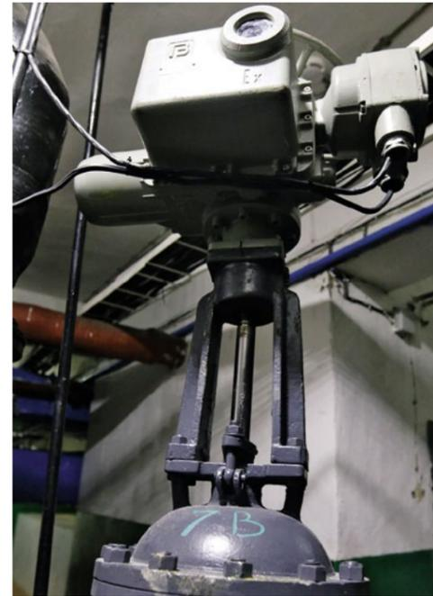
Ремонт моторной задвижки техводоснабжения для охлаждения ГА-3 выполнен хозспособом
