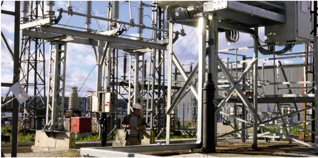
Реконструкция защит ОРУ-110 кВ на Кондопожской ГЭС
