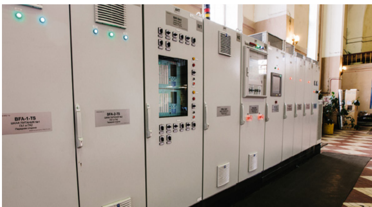
Машинный зал Пальеозерской ГЭС после демонтажа котлов МНУ
