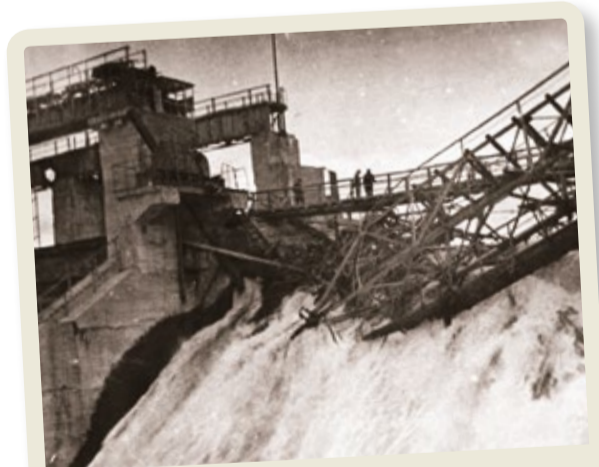
Взорванный подкрановый путь на плотине Нижне-Свирской ГЭС, зима 1944 г.
