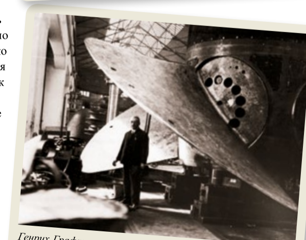
Генрих Графтио на строящейся Нижне-Свирской ГЭС
