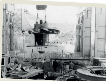
1989 год, август. Монтаж гидротурбины № 1
