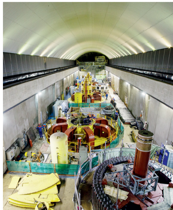
Все основное новое оборудование для сборки уже доставлено на станцию, что позволит значительно сократить срок монтажа
