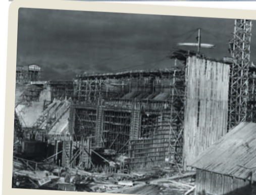
Восстановление Янискоски ГЭС. 1949 г.
