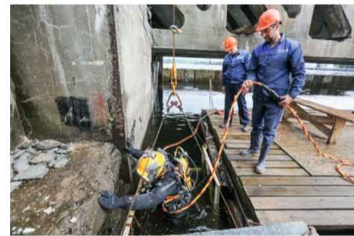
Работы по подводному бетонированию
